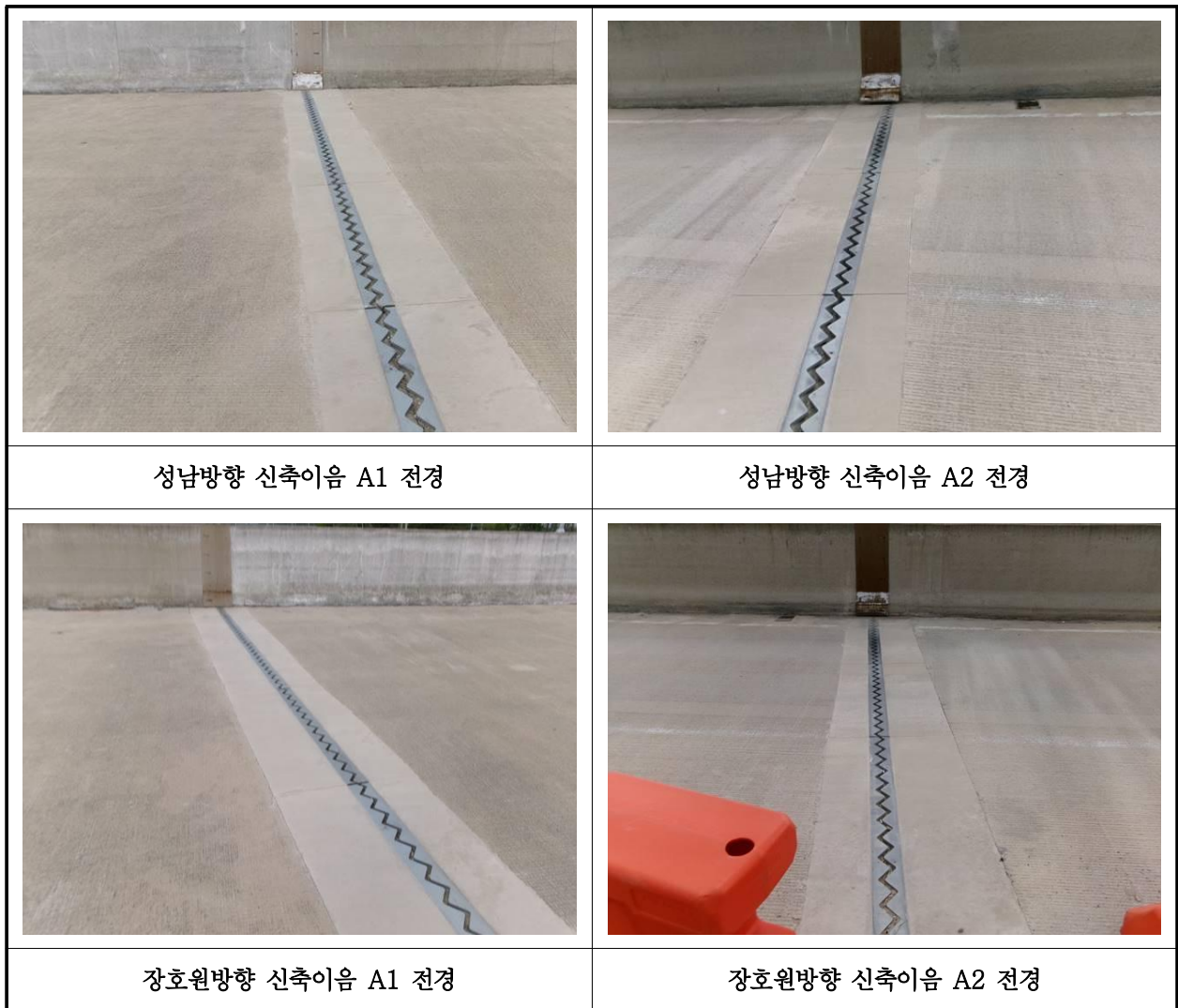
【사진 1.2.3】 신축이음장치 현황
